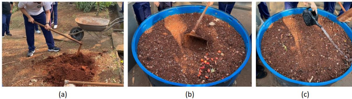
Figura 6. Preparação da caixa d'água para o plantio
